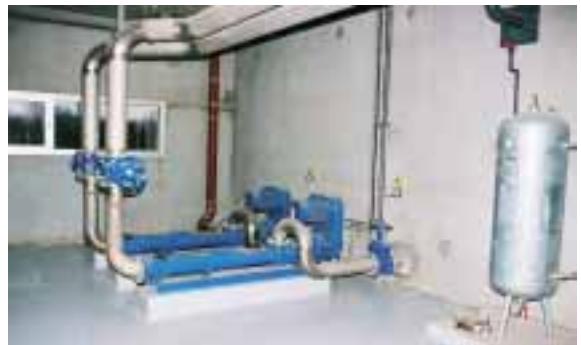
Polymerbeschickung (Hochdruck 15 bar) in Abhängigkeit der Schlammmenge
