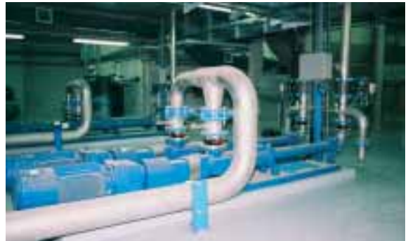
Filterpressenbeschickung mit 2 Moineaupumpen
